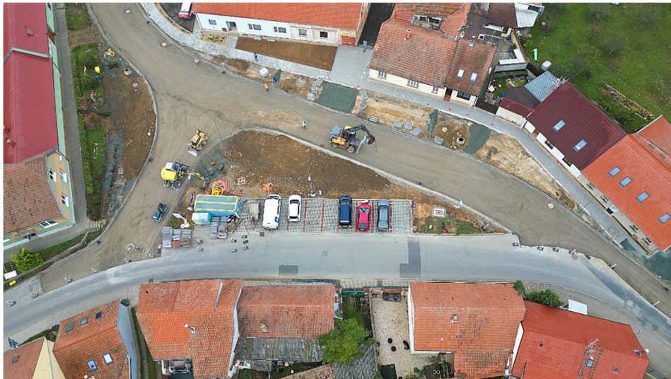
Rekonstrukce křižovatky Komenského – Tikovická – Jeřábkova, foto: Josef Maciček
